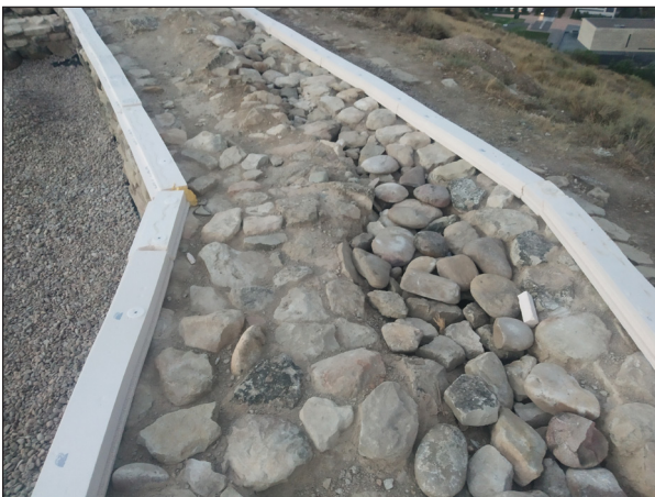
Encofrado de la cumbrera de la muralla. Campaña de 2022
