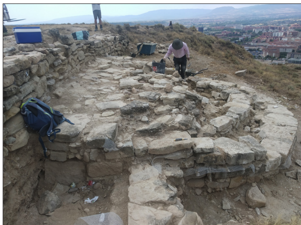
Trabajos de consolidación en el cubo ue 142. Campaña de 2022.
