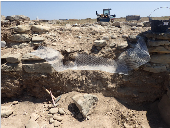
Delimitación de la consolidación mediante malla en el lienzo occidental de la muralla. Campaña de 2022.
