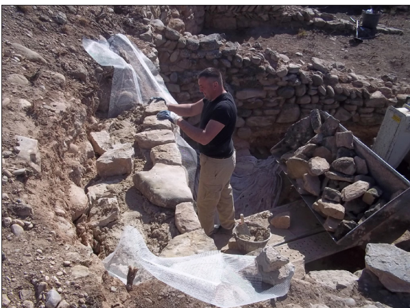
Colocación y ajustes de las piezas sobre la obra original. Campaña de 2018/2019.
