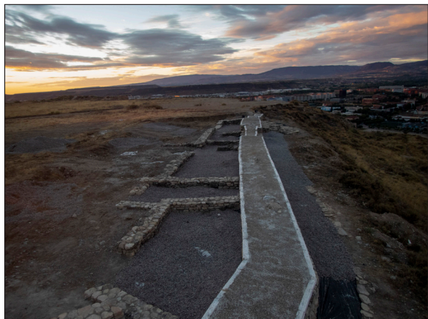
Tratamiento final de las superficies: extensión de gravilla en la zona cumbrera de la muralla, las habitaciones y el exterior del tramo occidental de la muralla. Campaña de 2022.
