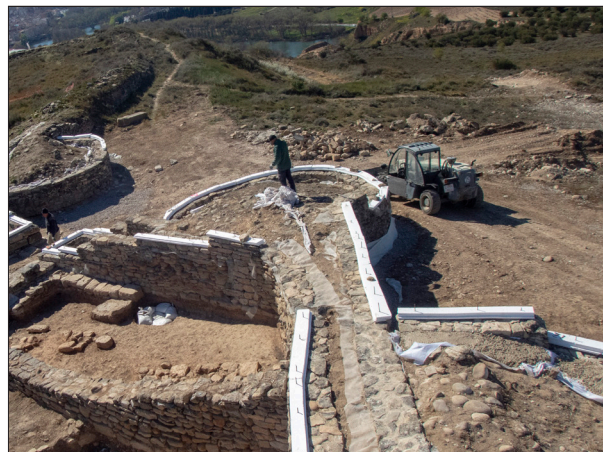
Disposición del encofrado de poliuretano expandido en la zona de la puerta. Campaña de 3018/2019.
