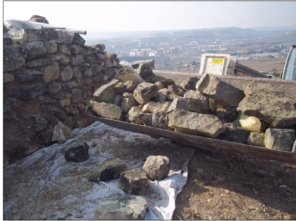
Aporte de piezas elegidas de sillarejo a pie de obra con medios mecánicos. Campaña de 2018/2019.
