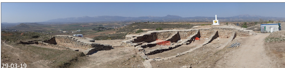
Registro fotográfico del avance de los trabajos de consolidación. Campaña de 2018/2019.
