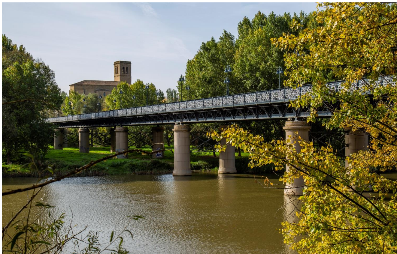
Imagen 6. Puente de Hierro.
