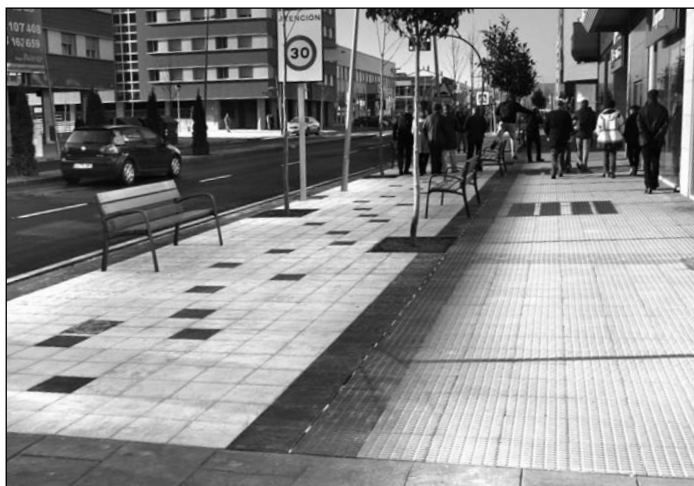
Tramo de Avenida de Burgos en el que el Ayuntamiento de Logroño está acometiendo las obras de remodelación.
