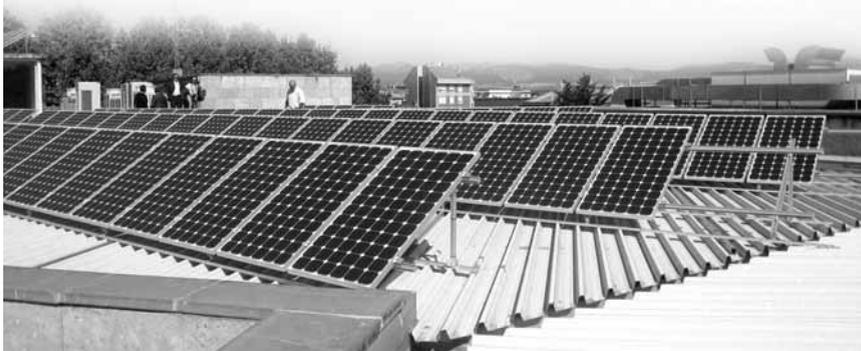
El próximo mes de octubre entrarán en funcionamiento los 350 módulos fotovoltaicos instalados en la cubierta del Ayuntamiento de Logroño, que permitirán obtener energía solar para cubrir la cuarta parte del consumo eléctrico del Consistorio.
