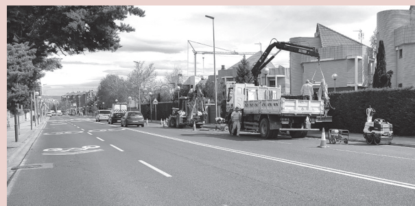
Renovación de arquetas en la avenida de Madrid.
