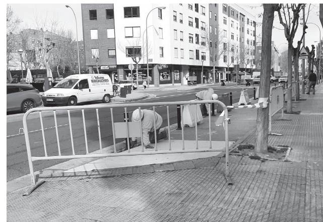
■ Obras de ensanche de aceras en la calle Siete Infantes de Lara.
